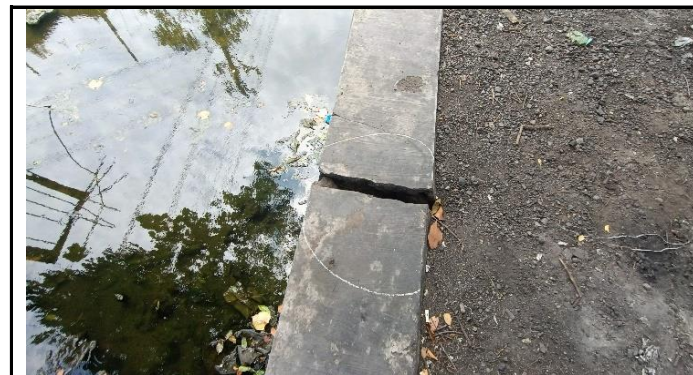
PARAPET RETAK
