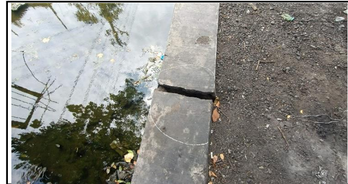
PARAPET RETAK
