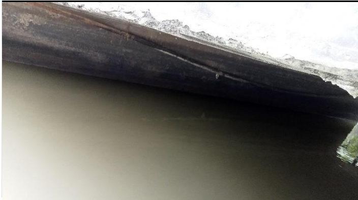
KONDISI BANGUNAN BAWAH
