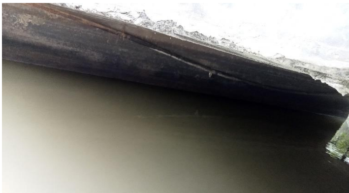
KONDISI BANGUNAN BAWAH
