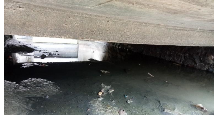
KONDISI BANGUNAN BAWAH
