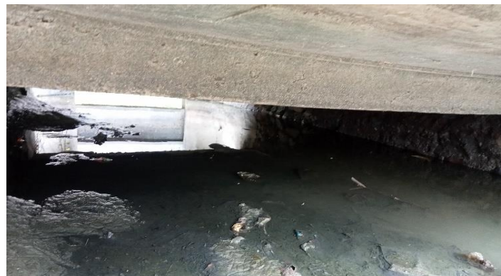
KONDISI BANGUNAN BAWAH
