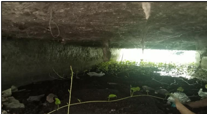
KONDISI BANGUNAN BAWAH
