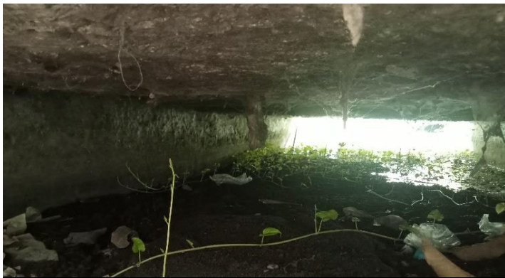
KONDISI BANGUNAN BAWAH
