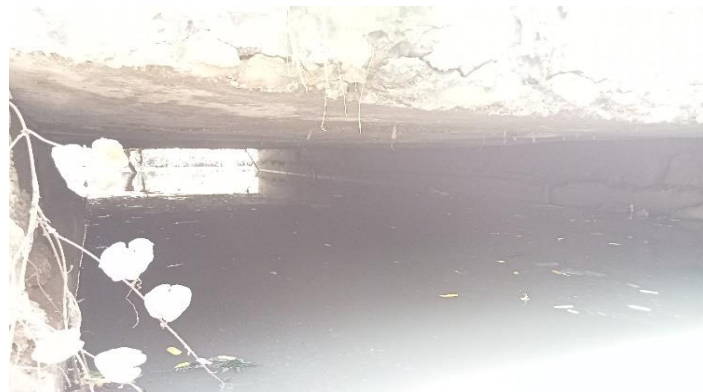
KONDISI BANGUNAN BAWAH
