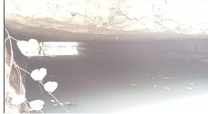
KONDISI BANGUNAN BAWAH
