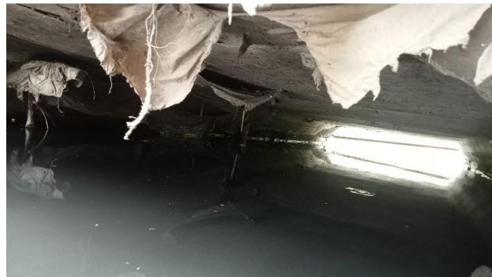
KONDISI BANGUNAN BAWAH
