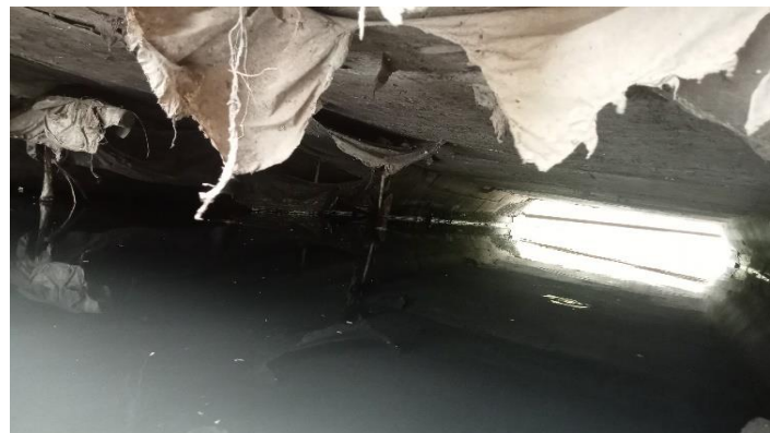
KONDISI BANGUNAN BAWAH
