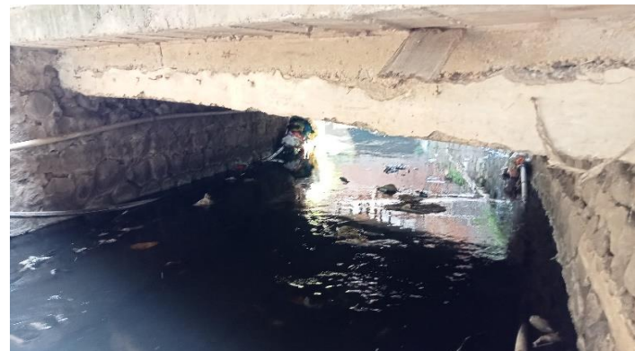
KONDISI BANGUNAN BAWAH
