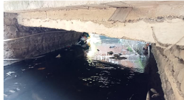
KONDISI BANGUNAN BAWAH
