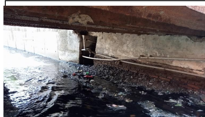
KONDISI BANGUNAN BAWAH
