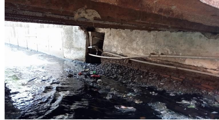
KONDISI BANGUNAN BAWAH
