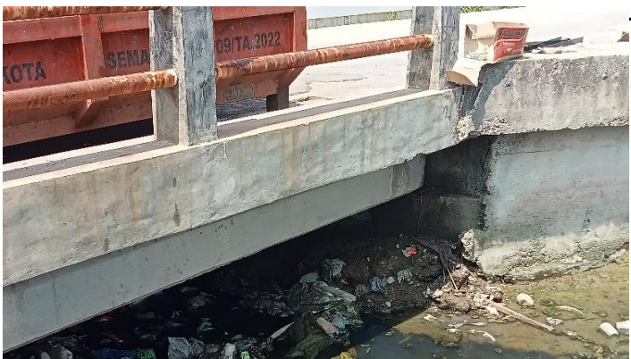
KONDISI BANGUNAN BAWAH
