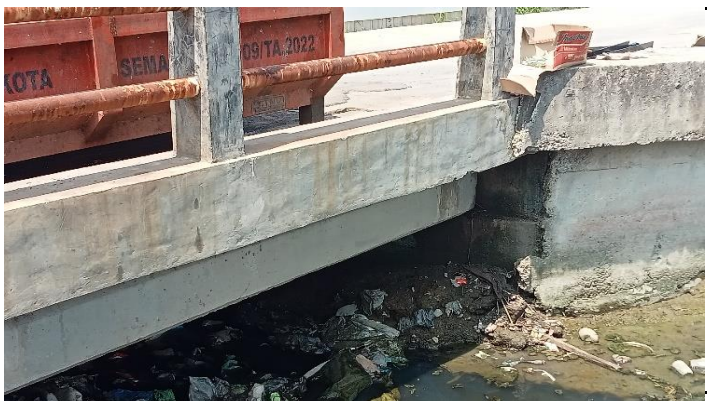
KONDISI BANGUNAN BAWAH
