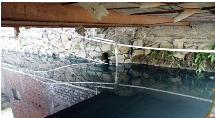
KONDISI BANGUNAN BAWAH
