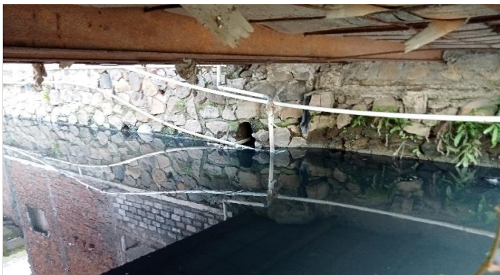
KONDISI BANGUNAN BAWAH
