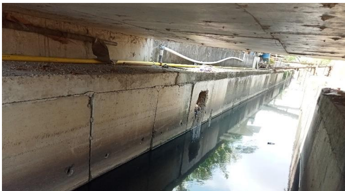
KONDISI BANGUNAN BAWAH
