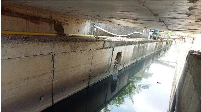
KONDISI BANGUNAN BAWAH
