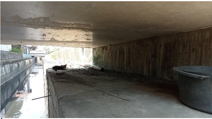
KONDISI BANGUNAN BAWAH
