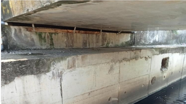
KONDISI BANGUNAN BAWAH
