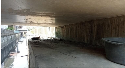
KONDISI BANGUNAN BAWAH
