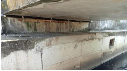
KONDISI BANGUNAN BAWAH
