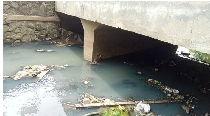
KONDISI BANGUNAN BAWAH
