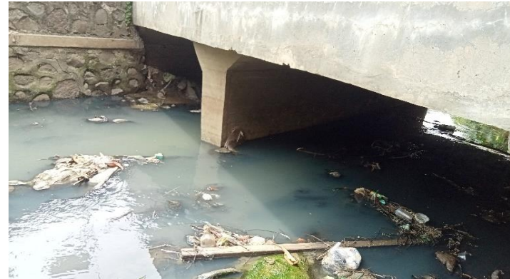
KONDISI BANGUNAN BAWAH
