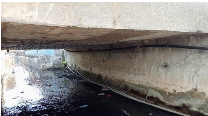
KONDISI BANGUNAN BAWAH
