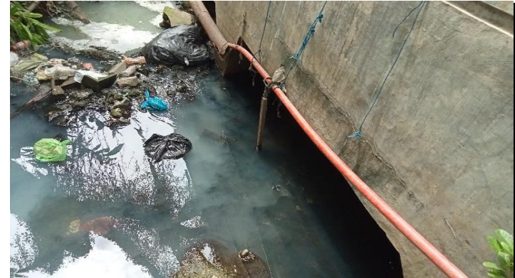
KONDISI BANGUNAN BAWAH
