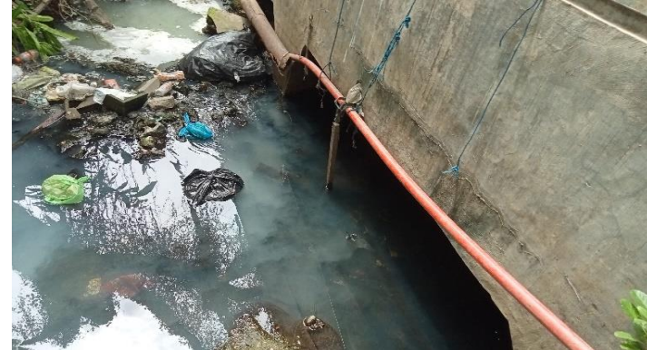
KONDISI BANGUNAN BAWAH
