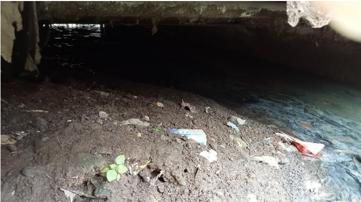
KONDISI BANGUNAN BAWAH
