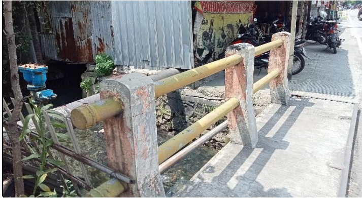
KONDISI SANDARAN DAN TROTOAR
