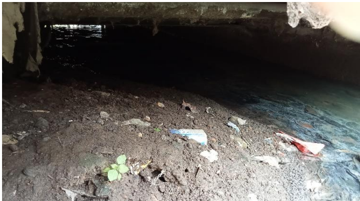
KONDISI BANGUNAN BAWAH
