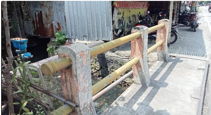
KONDISI SANDARAN DAN TROTOAR
