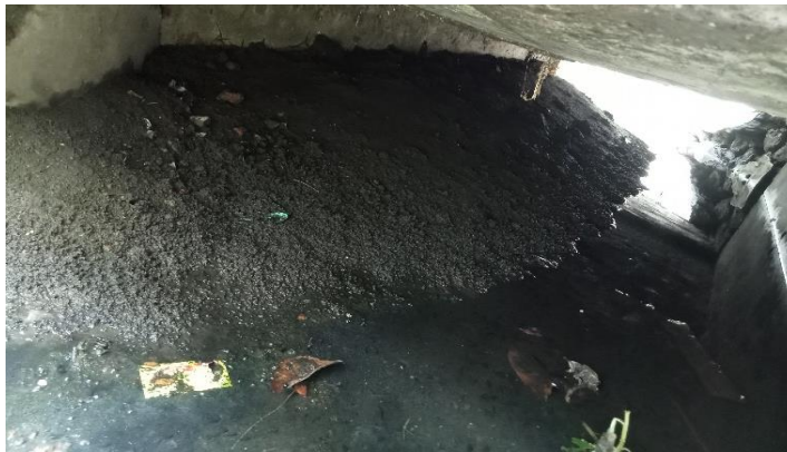
KONDISI BANGUNAN BAWAH
