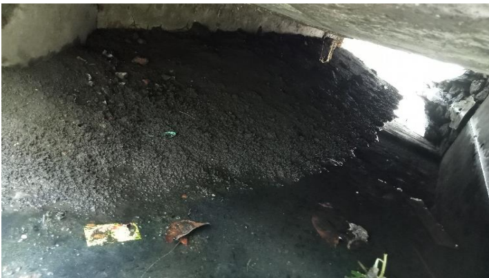
KONDISI BANGUNAN BAWAH
