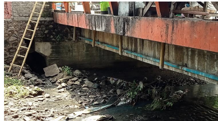
KONDISI BANGUNAN BAWAH
