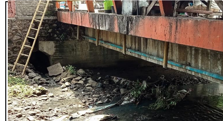
KONDISI BANGUNAN BAWAH
