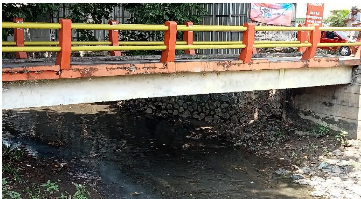
KONDISI BANGUNAN BAWAH
