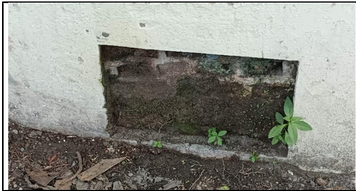
PAPAN NAMA JEMBATAN TIDAK ADA
