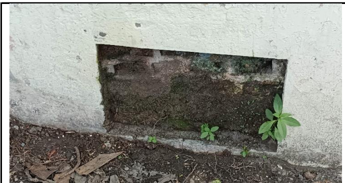
PAPAN NAMA JEMBATAN TIDAK ADA
