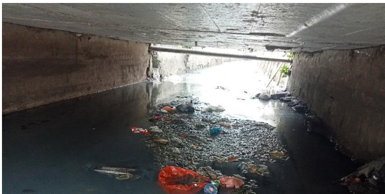
KONDISI BANGUNAN BAWAH
