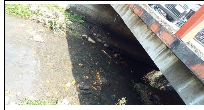
KONDISI BANGUNAN BAWAH
