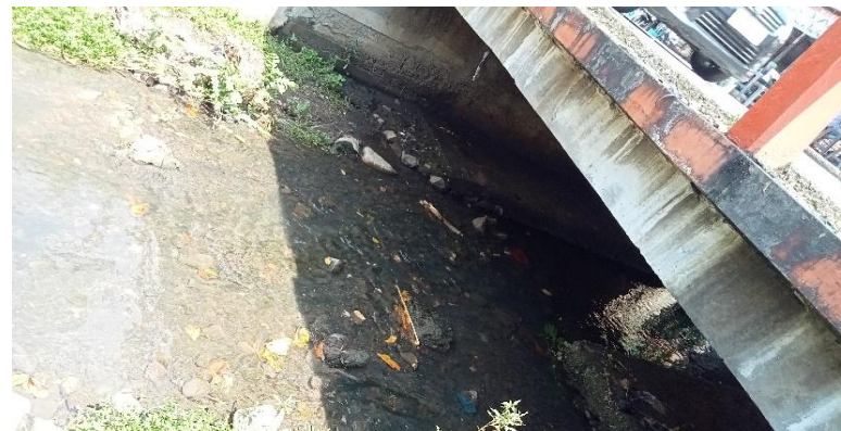
KONDISI BANGUNAN BAWAH
