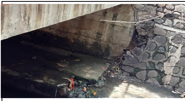
KONDISI BANGUNAN BAWAH
