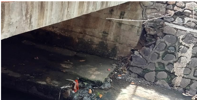
KONDISI BANGUNAN BAWAH
