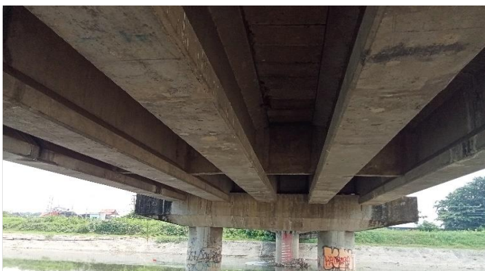
KONDISI BANGUNAN BAWAH
