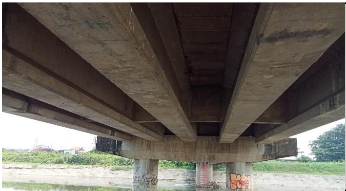
KONDISI BANGUNAN BAWAH
