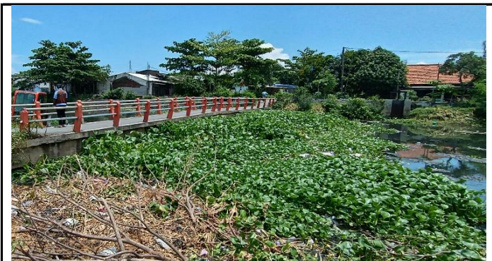
PENUMPUKAN DEBRIS PADA ALIRAN SUNGAI
