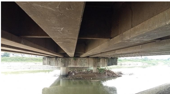
KONDISI BANGUNAN BAWAH
