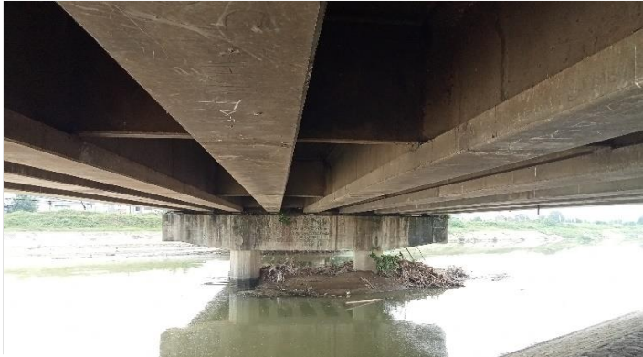
KONDISI BANGUNAN BAWAH
