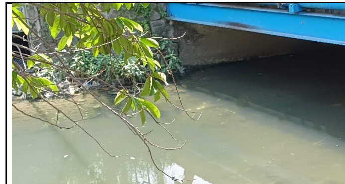
KONDISI BANGUNAN BAWAH
