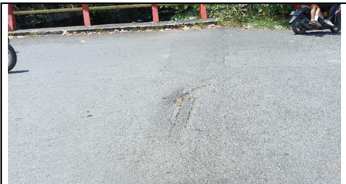
LAPISAN PERMUKAAN JALAN BERLUBANG
