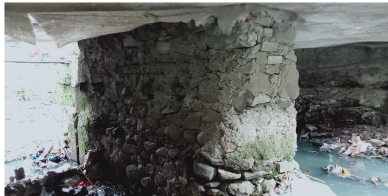
KONDISI BANGUNAN BAWAH
