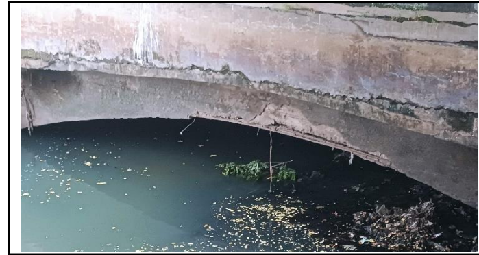
KONDISI PELENGKUNG JEMBATAN KEROPOS
