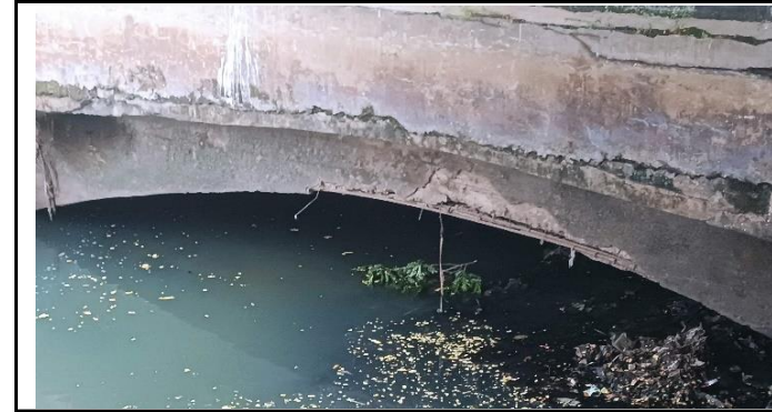
KONDISI PELENGKUNG JEMBATAN KEROPOS
