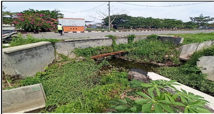
KONDISI SAMPIING KIRI JEMBATAN
