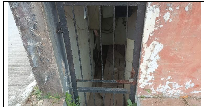
KONDISI BANGUNAN RUMAH POMPA YANG ADA DI ATAS JEMBATAN
