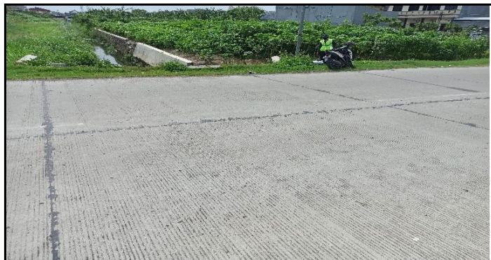
KONDISI LANTAI JEMBATAN
