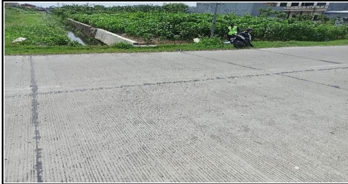
KONDISI LANTAI JEMBATAN
