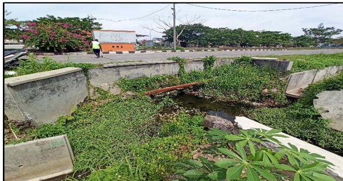
KONDISI JEMBATAN DARI SISI KIRI
