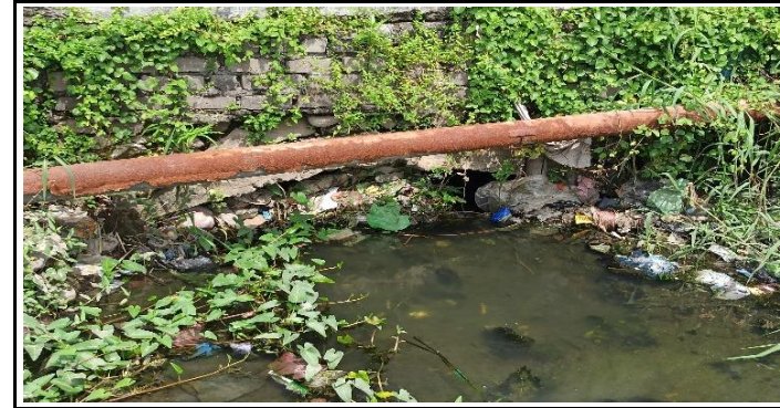
KONDISI BANGUNAN BAWAH
