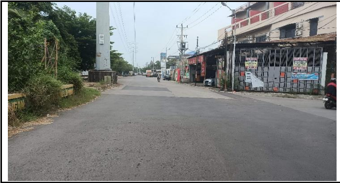
LAPIS PERMUKAAN LANTAI TIDAK SAMA TINGGI
