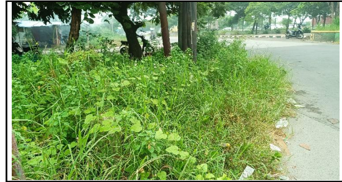
JEMBATAN DITUMBUHI SEMAK BELUKAR
