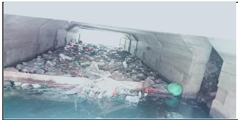
KONDISI BANGUNAN BAWAH
