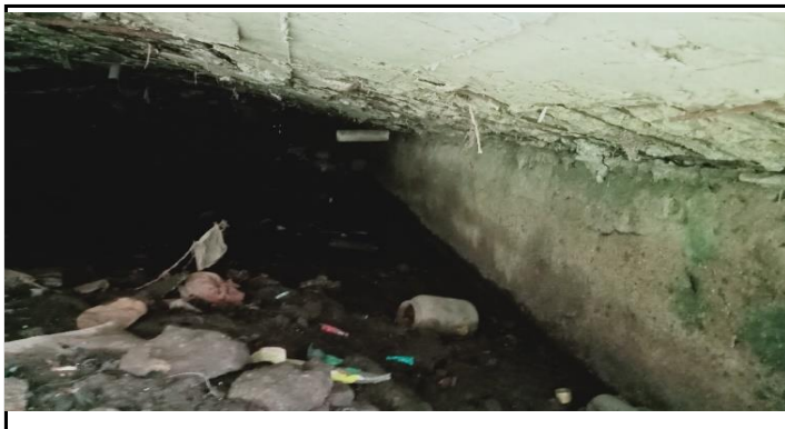
KONDISI BANGUNAN BAWAH
