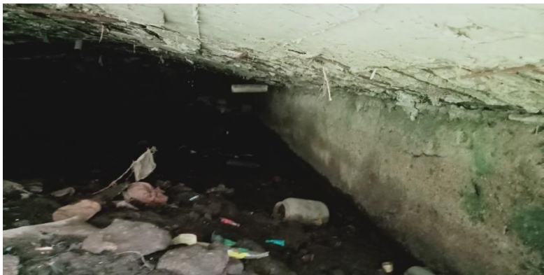
KONDISI BANGUNAN BAWAH
