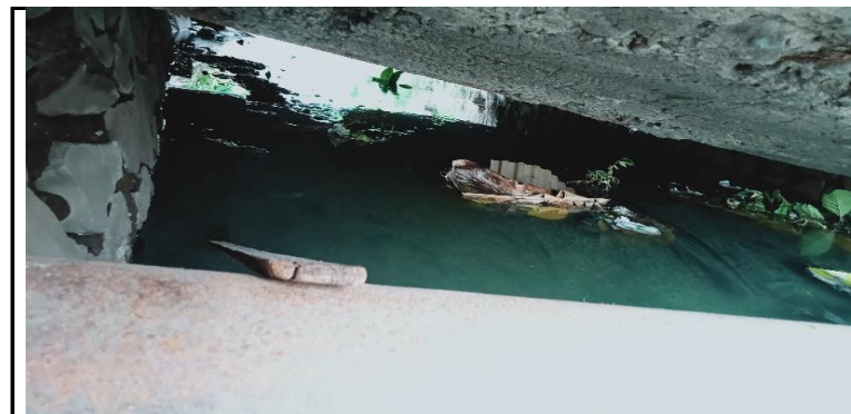
KONDISI BANGUNAN BAWAH
