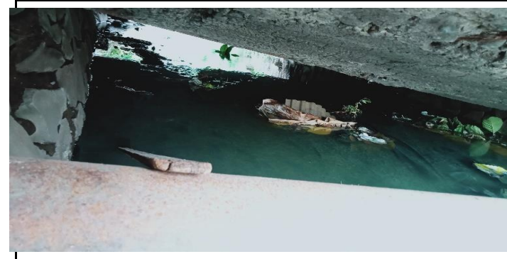
KONDISI BANGUNAN BAWAH
