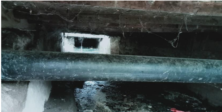
KONDISI BANGUNAN BAWAH
