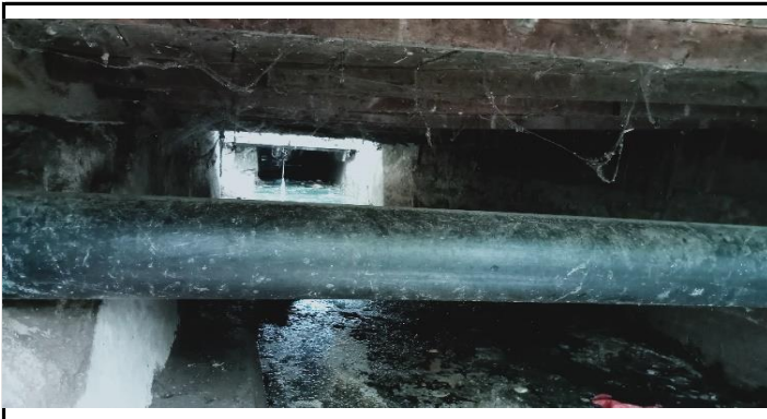
KONDISI BANGUNAN BAWAH
