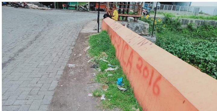
KONDISI SANDARAN KANAN
