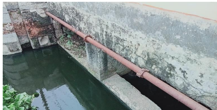
KONDISI BANGUNAN BAWAH
