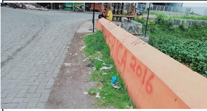
KONDISI SANDARAN KANAN
