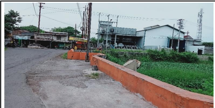
KONDISI SANDARAN KANAN
