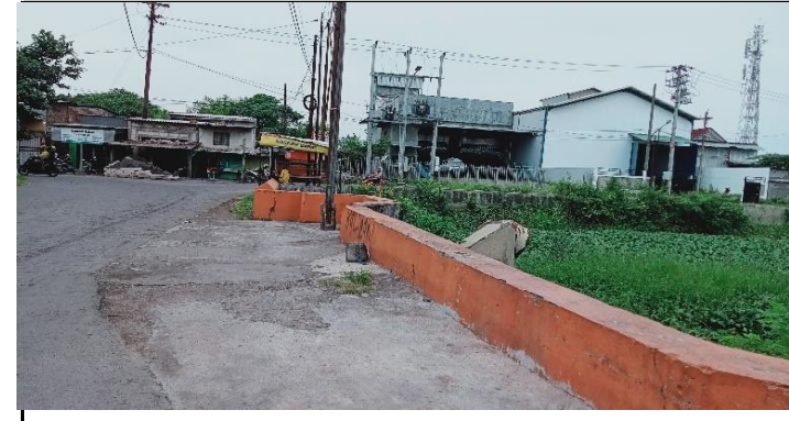
KONDISI SANDARAN KANAN
