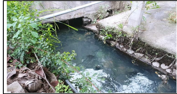
KONDISI PENGAMAN ALIRAN SUNGAI
