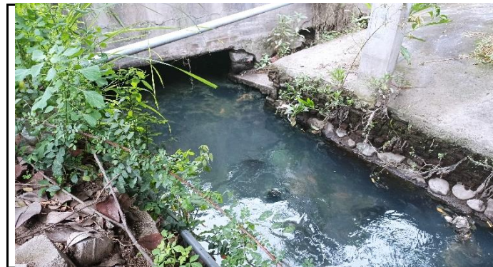
KONDISI PENGAMAN ALIRAN SUNGAI
