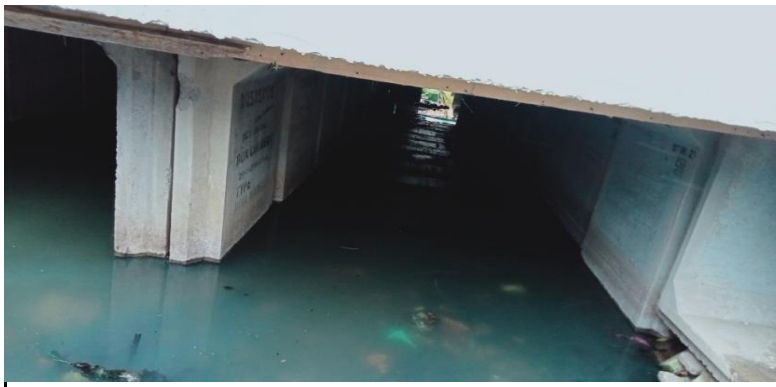
KONDISI BANGUNAN BAWAH
