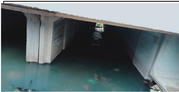
KONDISI BANGUNAN BAWAH
