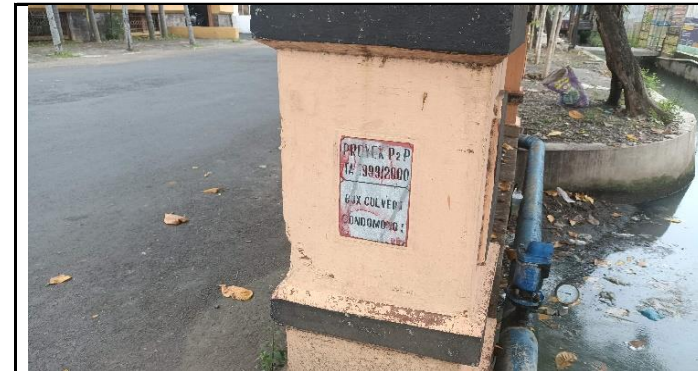
PAPAN NAMA JEMBATAN
