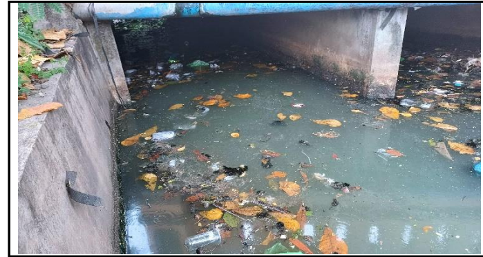
KONDISI BANGUNAN BAWAH
