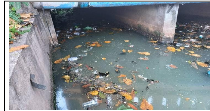
KONDISI BANGUNAN BAWAH
