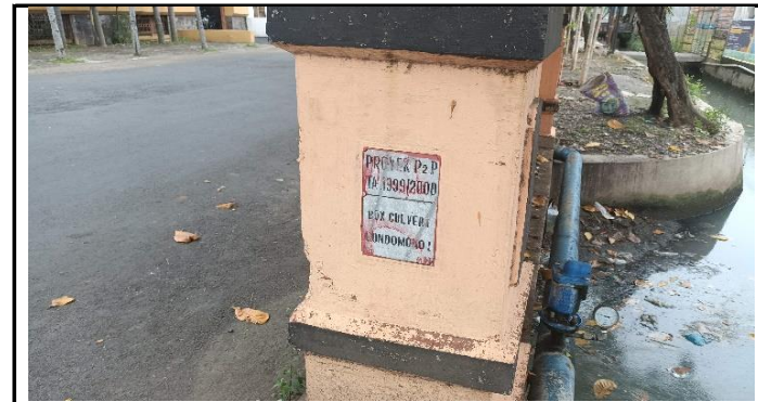
PAPAN NAMA JEMBATAN
