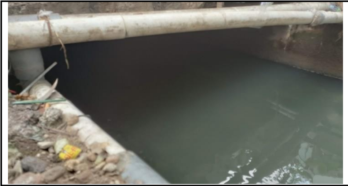
KONDISI BANGUNAN BAWAH
