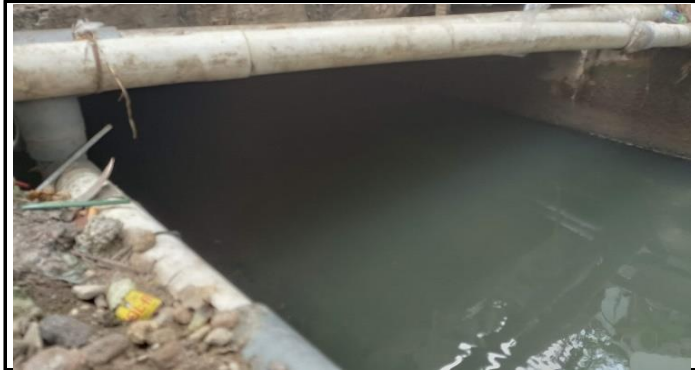
KONDISI BANGUNAN BAWAH
