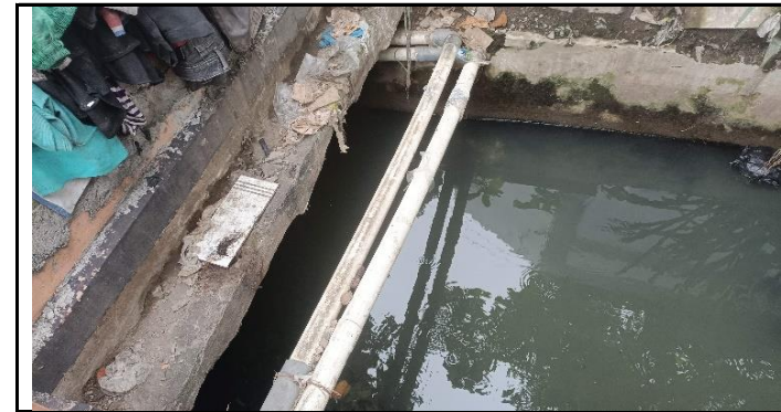
KONDISI PIPA UTILITAS
