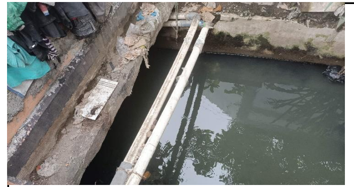
KONDISI PIPA UTILITAS
