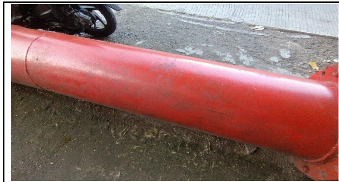
KONDISI PARAPET (TEMBOK SEDADA)
