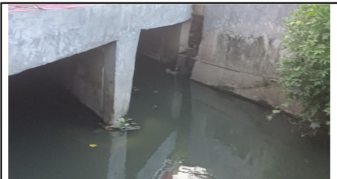
KONDISI BANGUNAN BAWAH
