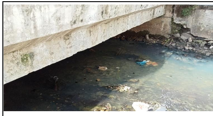
KONDISI BANGUNAN BAWAH
