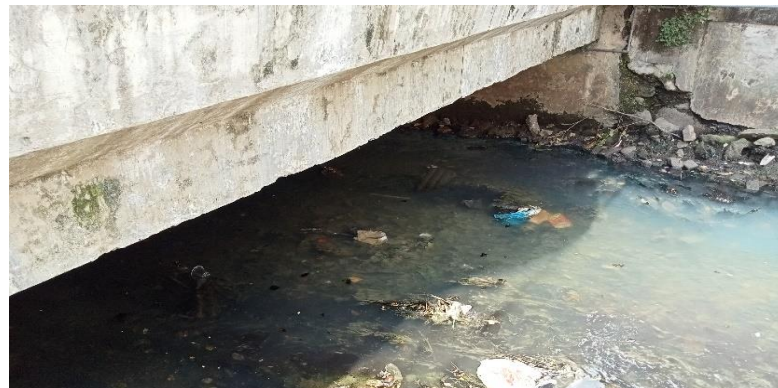
KONDISI BANGUNAN BAWAH
