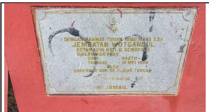
KONDISI PAPAN NAMA JEMBATAN
