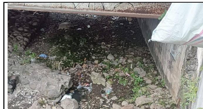
KONDISI BANGUNAN BAWAH
