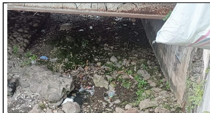
KONDISI BANGUNAN BAWAH
