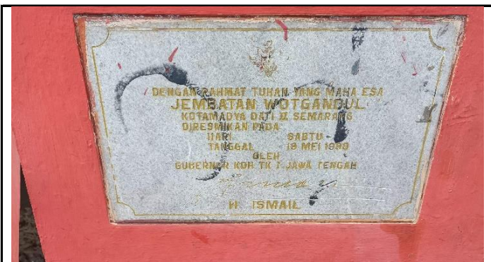
KONDISI PAPAN NAMA JEMBATAN
