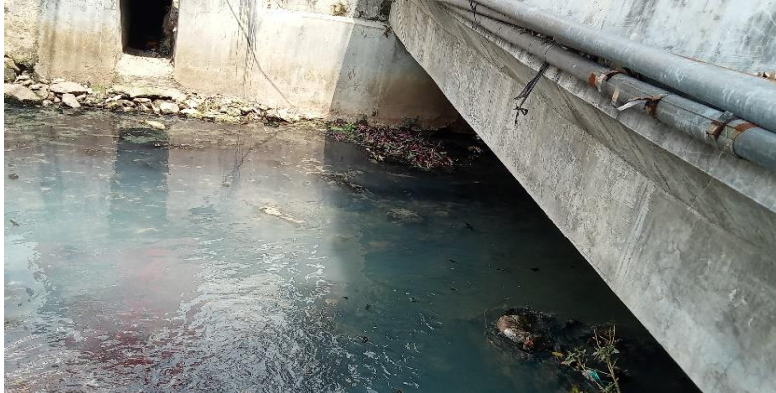
KONDISI BANGUNAN BAWAAH
