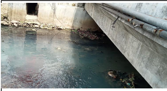
KONDISI BANGUNAN BAWAAH
