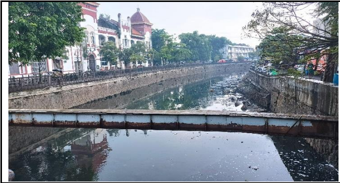
KONDISI PIPA UTILITAS DAN ALIRAN SUNGAI
