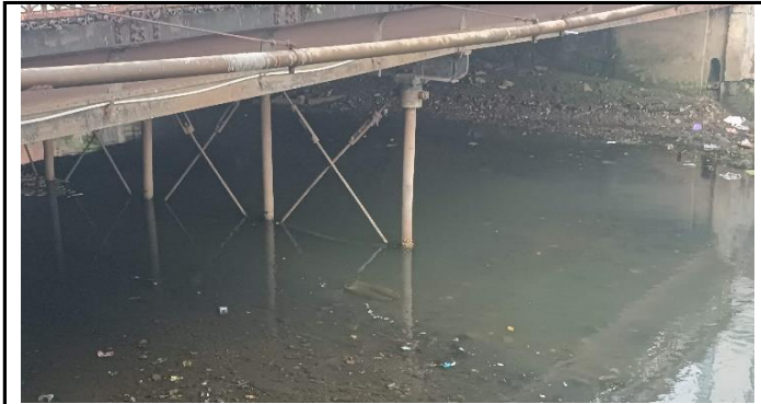
KONDISI PILAR JEMBATAN
