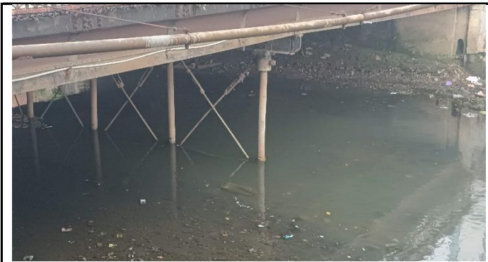
KONDISI PILAR JEMBATAN
