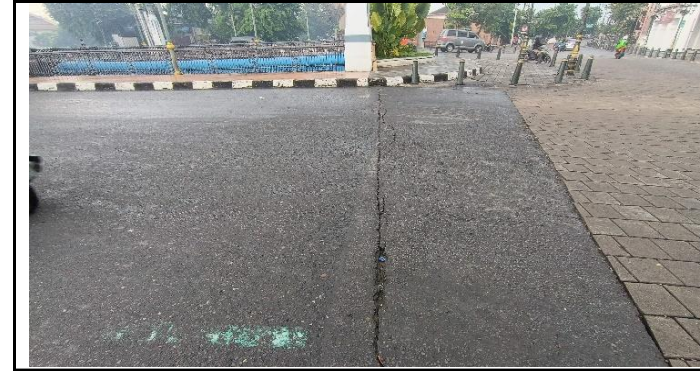
KONDISI BANGUNAN BAWAH
