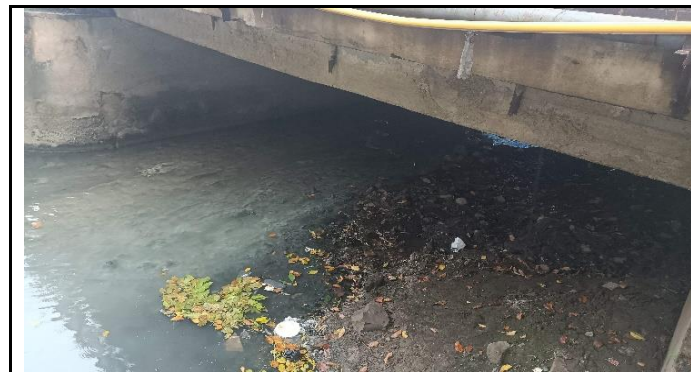
KONDISI BANGUNAN BAWAH
