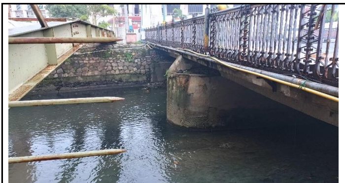
KONDISI PILAR JEMBATAN
