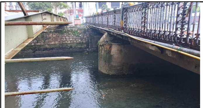
KONDISI PILAR JEMBATAN
