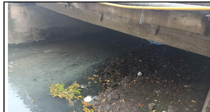
KONDISI BANGUNAN BAWAH
