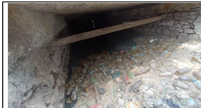
KONDISI BANGUNAN BAWAH
