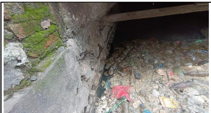
KONDISI KEPALA JEMBATAN
