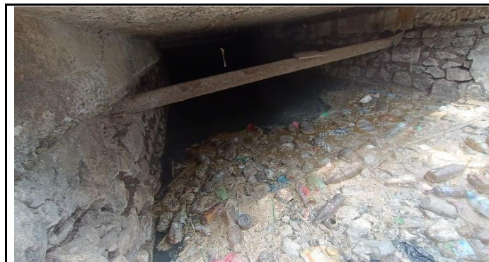
KONDISI BANGUNAN BAWAH
