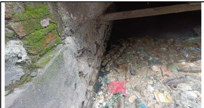
KONDISI KEPALA JEMBATAN
