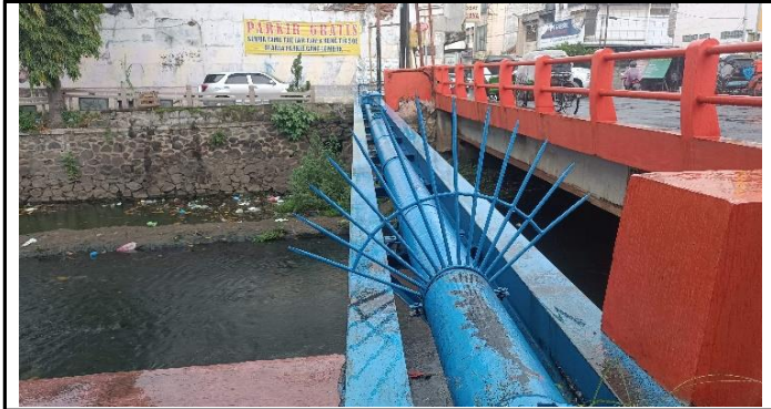
LAPISAN CAT MENGELUPAS PADA UTILITAS
