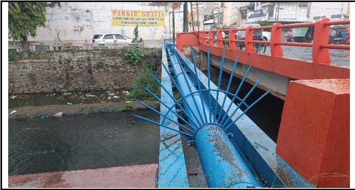
LAPISAN CAT MENGELUPAS PADA UTILITAS
