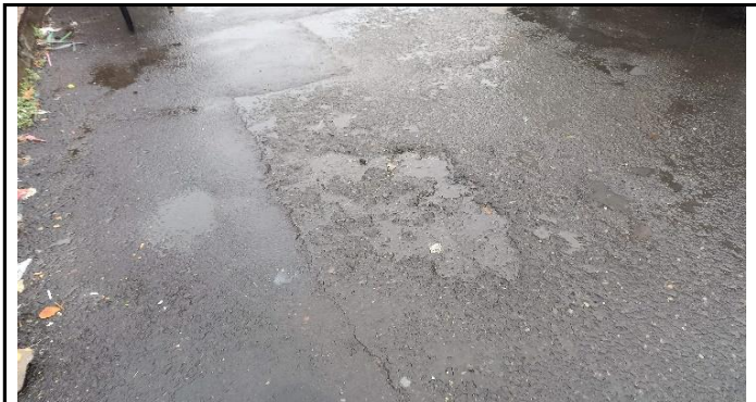
LAPISAN LANTAI PERMUKAAN BERLUBANG
