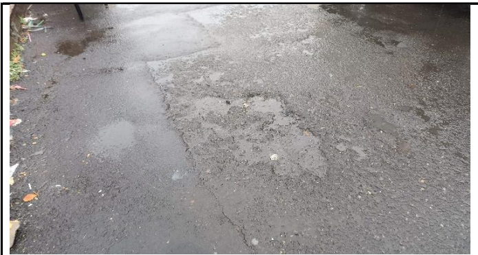
LAPISAN LANTAI PERMUKAAN BERLUBANG
