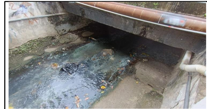
KONDISI BANGUNAN BAWAH
