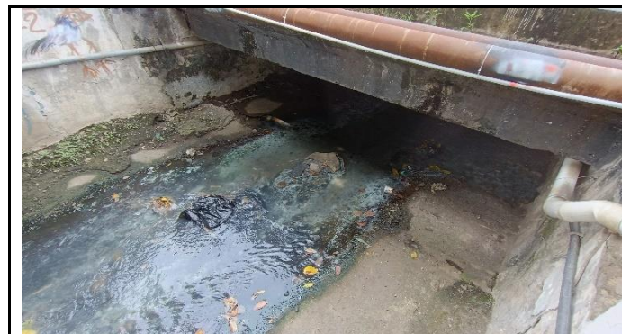
KONDISI BANGUNAN BAWAH
