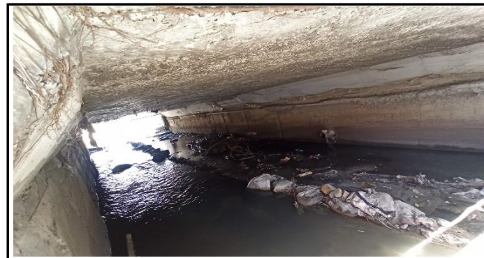
KONDISI BANGUNAN BAWAH JEMBATAN
