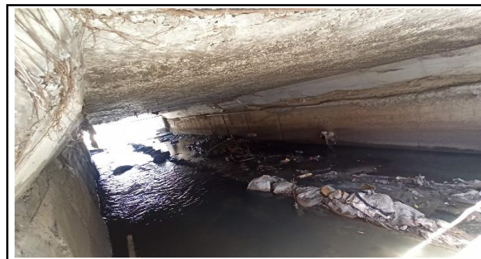
KONDISI BANGUNAN BAWAH JEMBATAN
